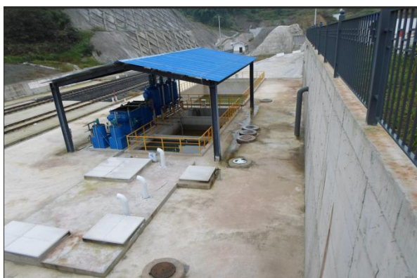
100 立方米隔油池及污水处理装置棚
