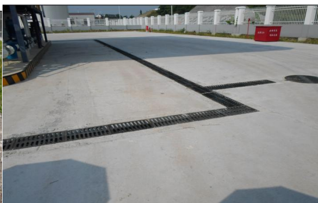
排污沟（发油区）
