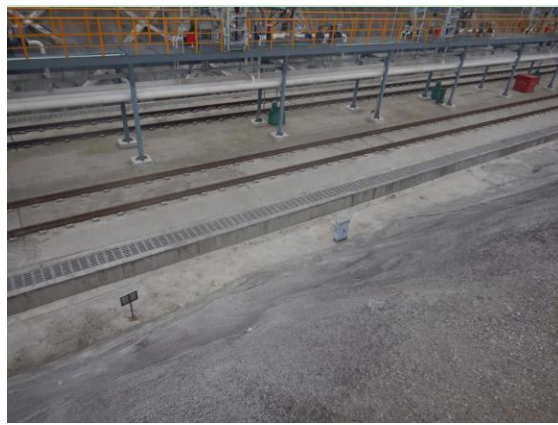
卸油区废水收集沟
